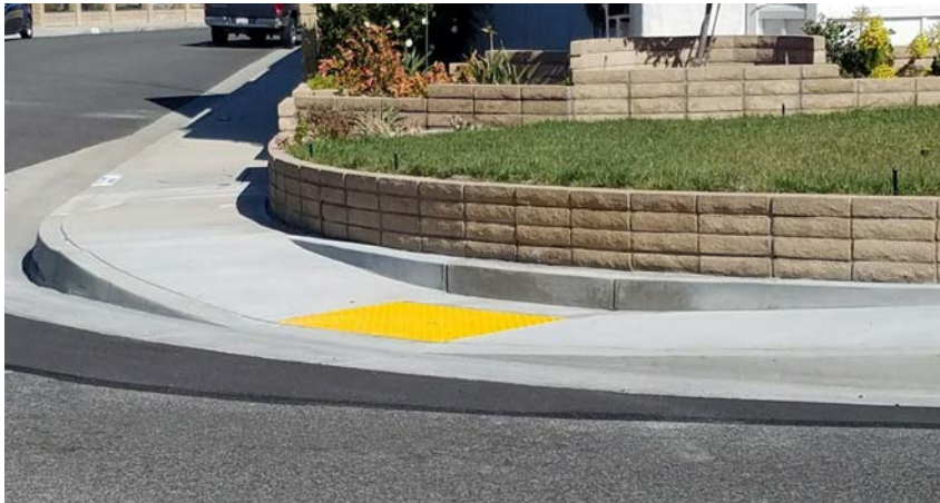
ADA Sidewalk Example
